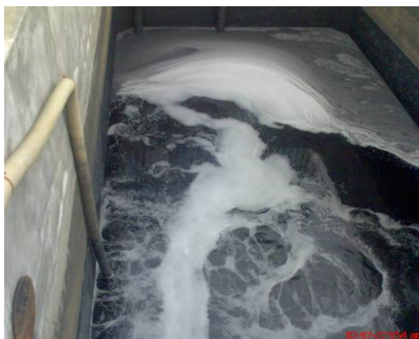
图 2 垃圾渗滤液收集池
