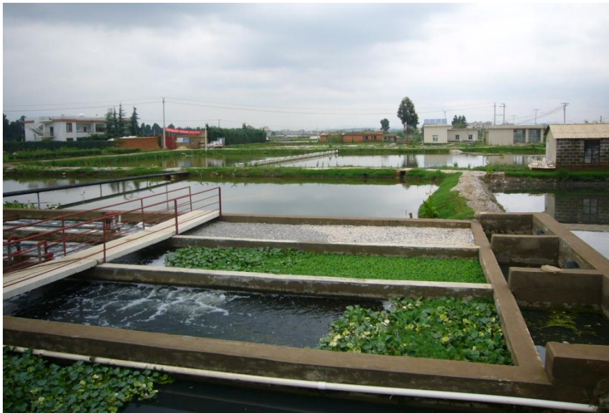
图 2 沟渠式生物接触氧化工艺的示范工程（2007 年 8 月）
